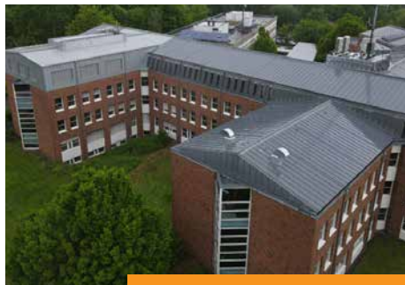
Aufstockung Polizeipräsidium Bielefeld im laufenden Betrieb
